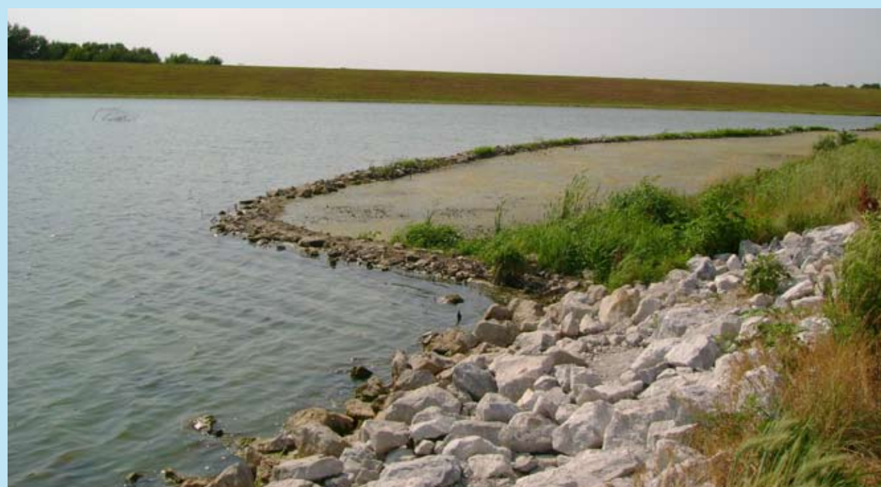
Sediment forebay example
